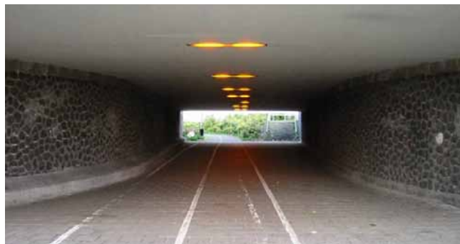
Figuur 5.10.2 Onderdoorgang onder het spoor
